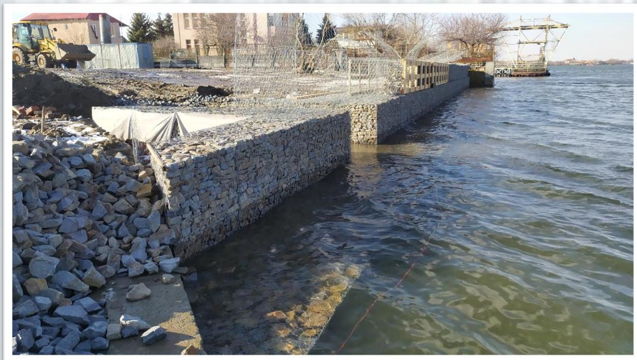
Нанесение разметки по контрольным точкам в соответствии с проектом и подготовка основания. На участке снимают плодородный слой, укладывают выравнивающий основание материал щебень или песчано-гравийную смесь.
