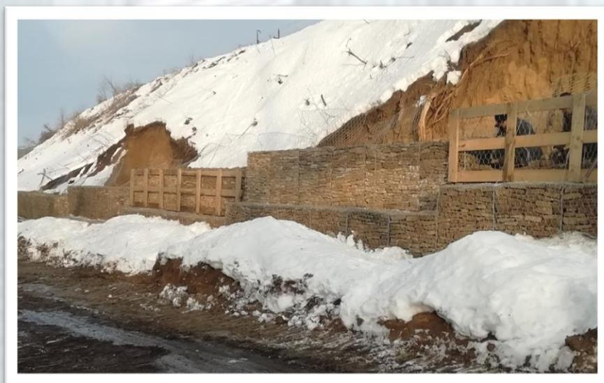
сетчатых изделий (ГСИ) включает учёт нормативных требований, методику расчёта и технологию монтажа. ГСИ – объёмные изделия различной формы из проволочной кручёной сетки с шестиугольными ячейками, предназначенные для
